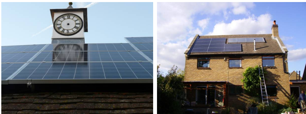
Slika 2.6 Tipični primjeri instalacije fotonaponskih modula na krovovima stambenih zgrada
