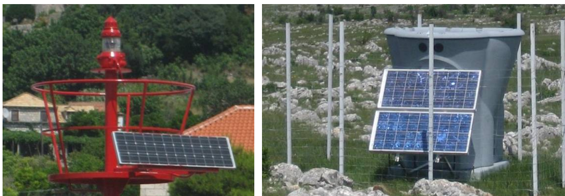
Slika 2.5 Tipični primjeri upotrebe fotonaponskih modula - lučko svjetlo (lijevo) i uređaj za mjerenje karakteristika vjetra ( desno ) (Izvor: EIHP)
