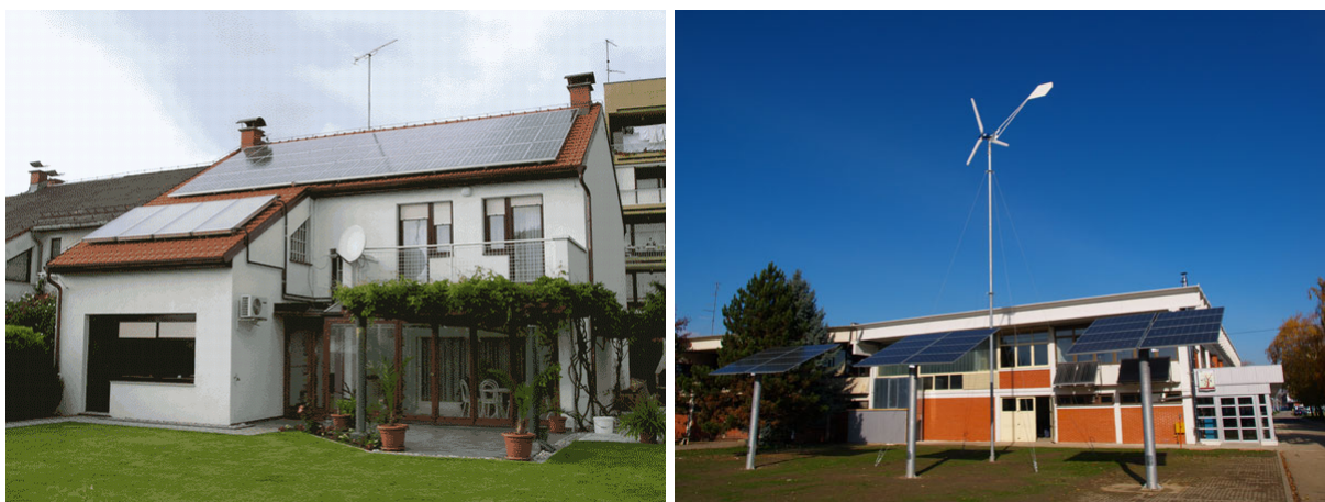
Slika 6.2 Primjeri postavljanja fotonaponskih modula (Izvor: EIHP)
