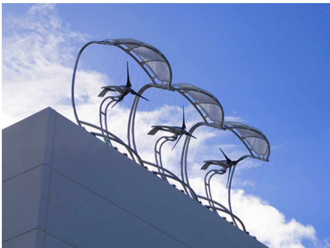
Slika 6.1 Smještaj malih vjetroagregata na rub ravnog krova
