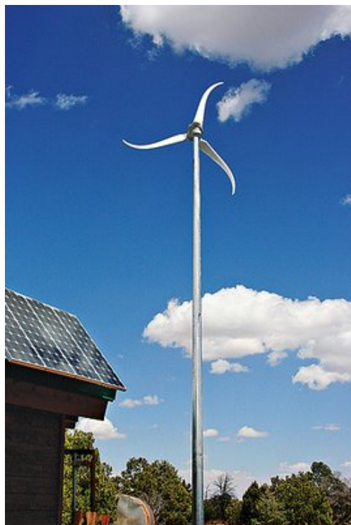
Slika 4.10 Tipični primjer malog autonomnog sustava (Skystream)
