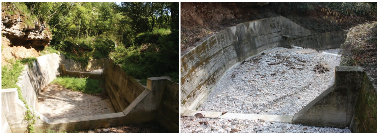
Slika 23. Pregrada za zadržavanje nanosa na bujici Mošćenička Draga 2004. ( lijevo ) i 2011. ( desno )
