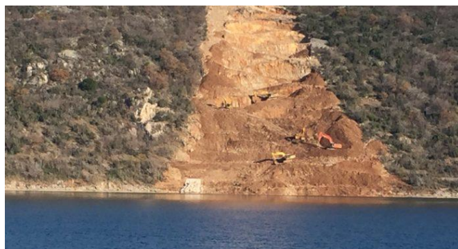
Slika 13 Radovi prilikom izgradnje naftovoda izvor: https://www.bkmontaza.hr/
