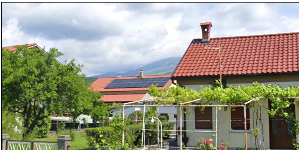
Slika 63: Obnovljivi izvori energije – solarni paneli na području Općine Jelenje
