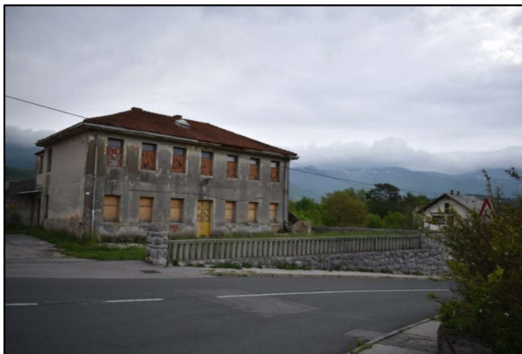
Slika 15: Zgrada stara škole u Jelenju
