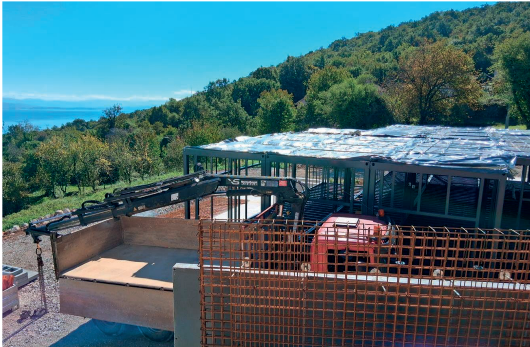
slika 9. radovi na izgradnji novog dječjeg vrtića u Rukavcu
