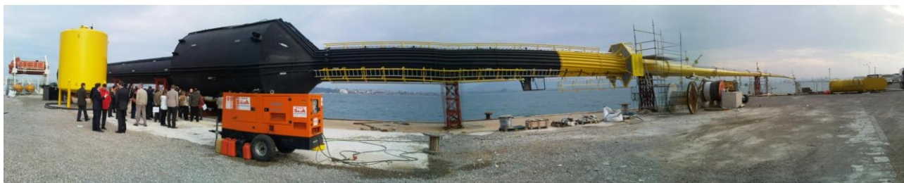
Slika 2.: Mjerni stup za ispitivanje kvalitete lokacije za offshore VE
