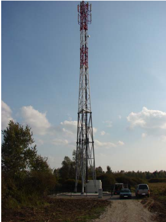
Fotografija 1 i 2: Primjer antenskih stupova za više operatera pokretnih komunikacija (AST 44-more i kopne te ACS 60-2 more)
