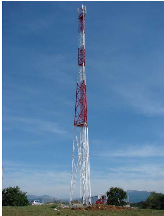
Fotografija 1 i 2: Primjer antenskih stupova za više operatera pokretnih komunikacija (AST 44-more i kopne te ACS 60-2 more)
