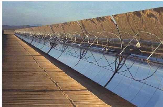
**Slika 13.** Parabolični kolektor
