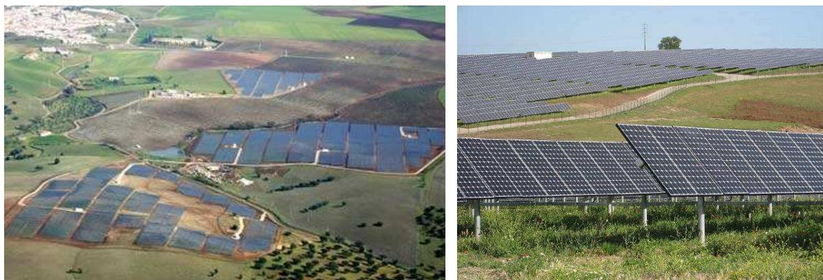
**Slika 12.** FN solarna elektrana Serpa (kraj Lisabona u Portugalu), instalirane snage 11 MW i godišnje proizvodnje veće od 18 GWh
