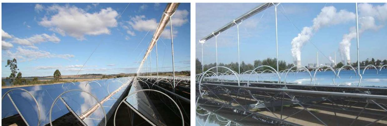
**Slika 20.** Fresnel reflektori tipa CLFR u Australiji (lijevo), koji rade u kogeneraciji s termoelektranama (desno). Uočljive su šine i valjci pomoću kojih se reflektori zakreću.
