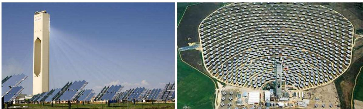
**Slika 25.** Prva komercijalna europska CSP sunčana termoelektrana Solucar PS10 u Sevilli (Španjolska) s 11 MW instalirane snage
