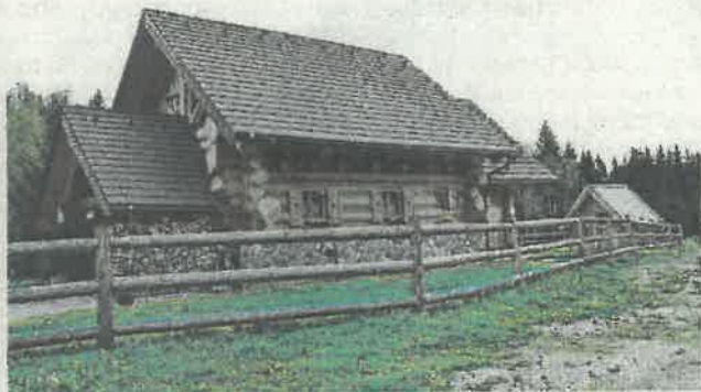
Ova se novogradnja uklopila u goranske okvire...
