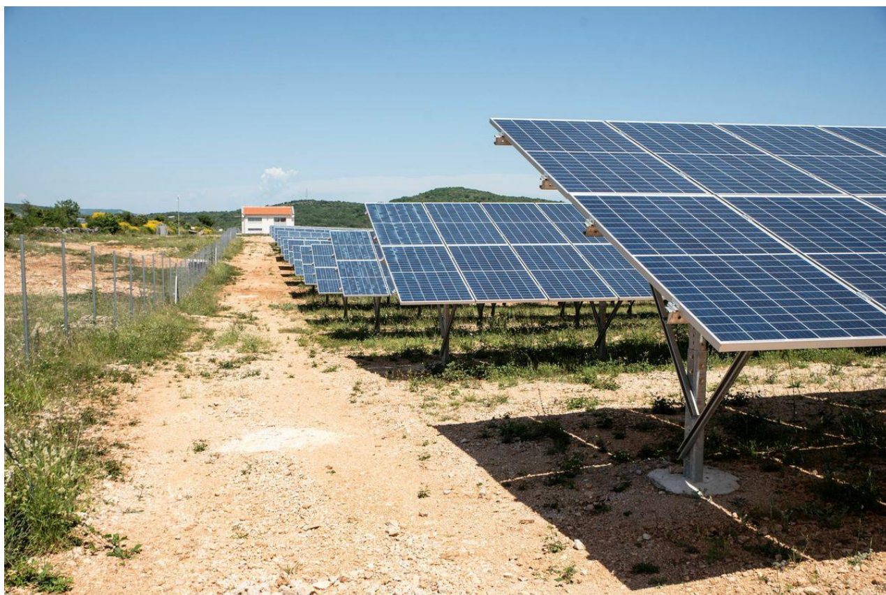
Radovi na SE Cres u završnoj su fazi / Foto Walter Salković
