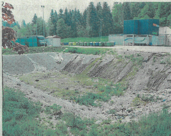
Pokušaj izgradnje kazete zaustavljen je prije 13 godina, a ostaci su i danas vidljivi
