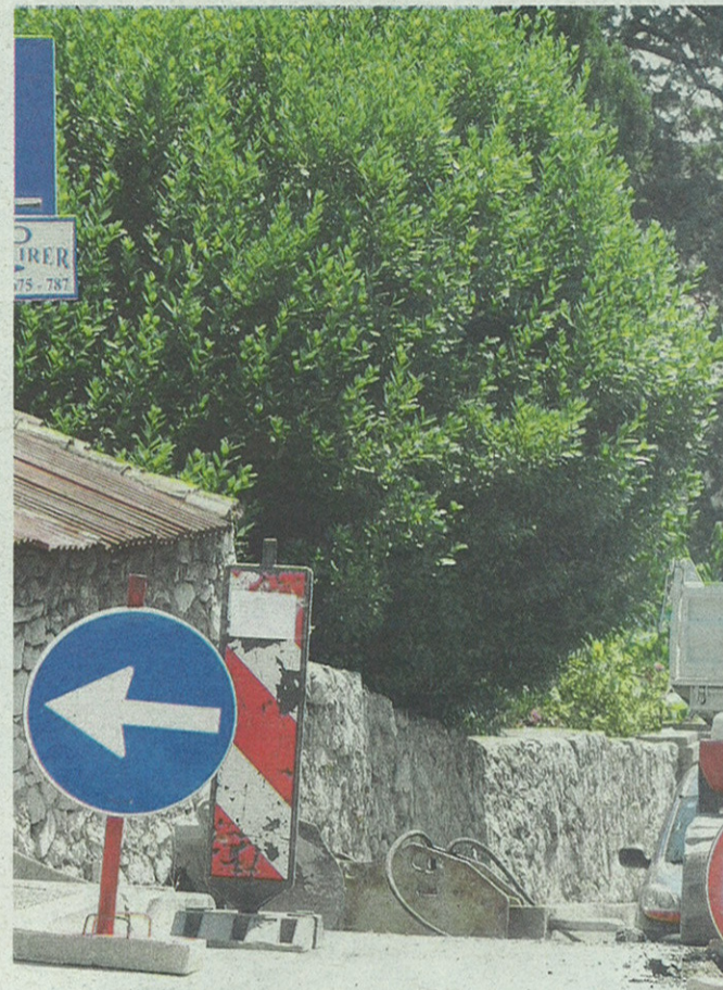
Ulica braće Branchetta bit će raskopana i »nevozna« gotovo dva mjeseca
